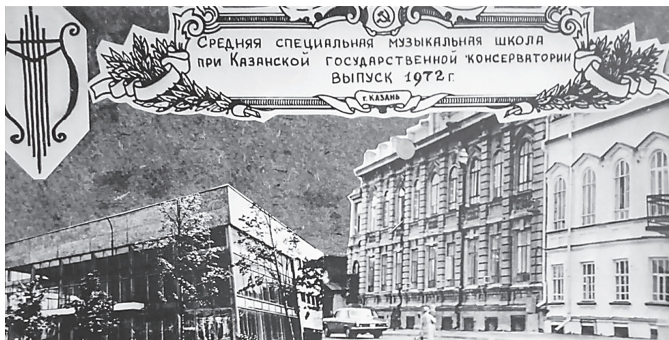
Здание ССМШ и Концертного зала
